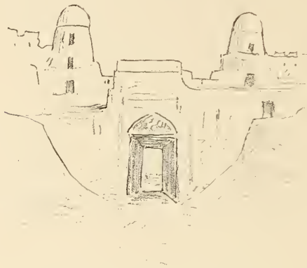
Porte de la forteresse (intérieur).
